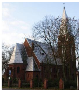
Dofinansowanie remontu dachu kościoła w Kłodawie
