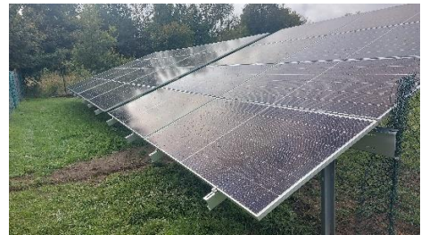
Montaż paneli fotowoltaicznych przy szkole w Różankach
