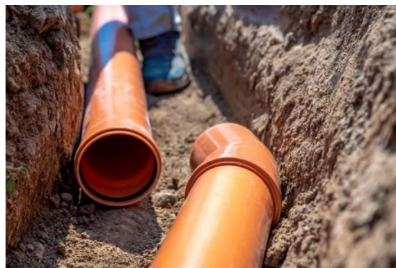
Budowa kanalizacji sanitarnej w Kłodawie oraz Mironicach
