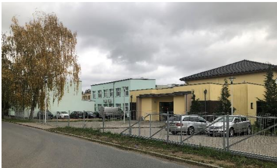
Wymiana części ogrodzenia budynku szkoły w Kłodawie
