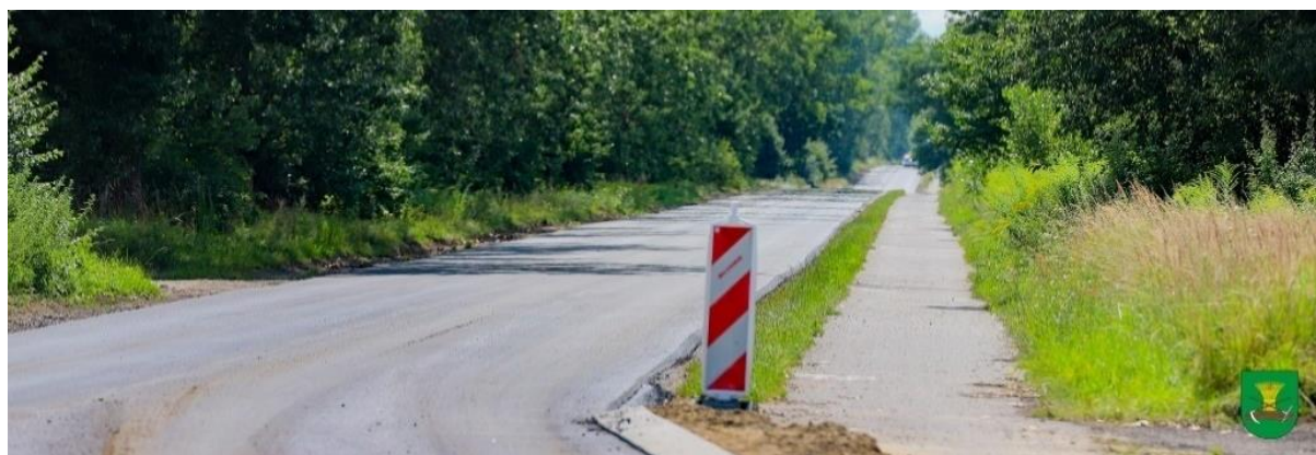
Remont drogi powiatowej Kłodawa - Wojciszce
