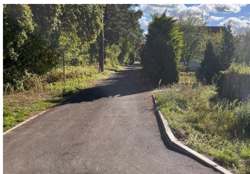
Remont ulicy Piaskowej w Różankach
