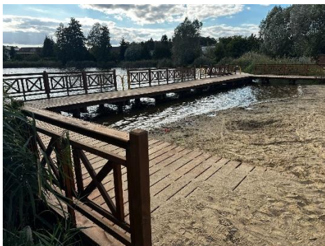
Modernizacja pomostu nad jez. Kłodawskim
