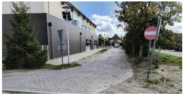
Budowa ulicy Makowej w Kłodawie
