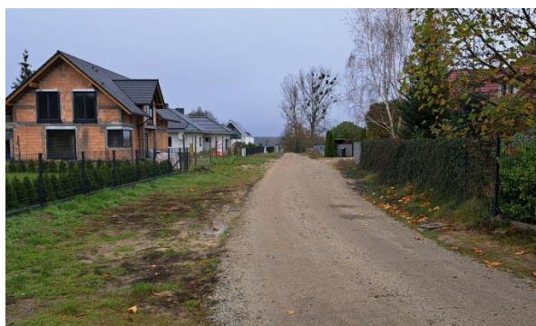
Remont ulicy Platanowej w Santocku
