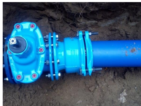
Budowa odcinka wodociągu w Rybakowie
