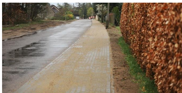
Budowa chodnika w Zdroisku
