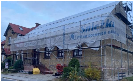
Remont świetlicy wiejskiej w Rybakowie
